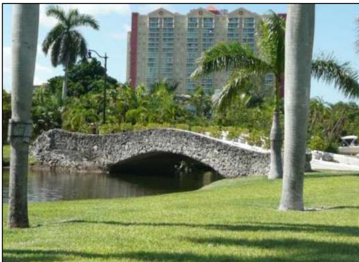
Photo 5-16. Sunny Isle Bridge #2, Miami-Dade County (No. 874218)
